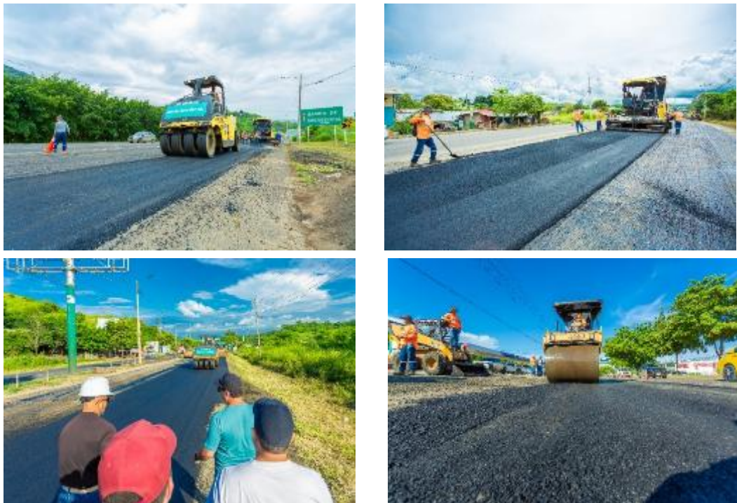
Ilustración 6: Recapeo carpeta asfáltica
