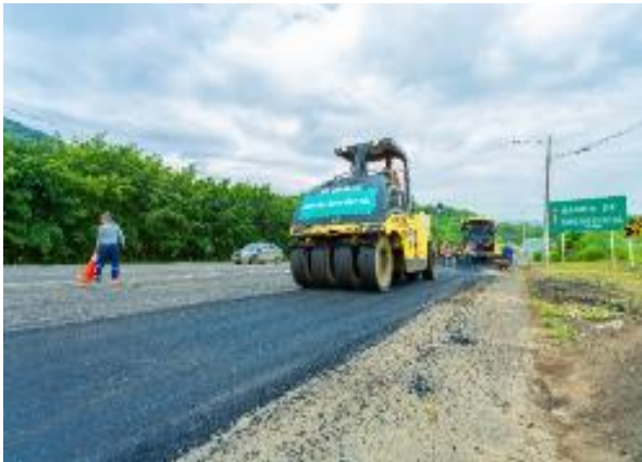
Ilustración 5: Recapeo carpeta asfáltica
