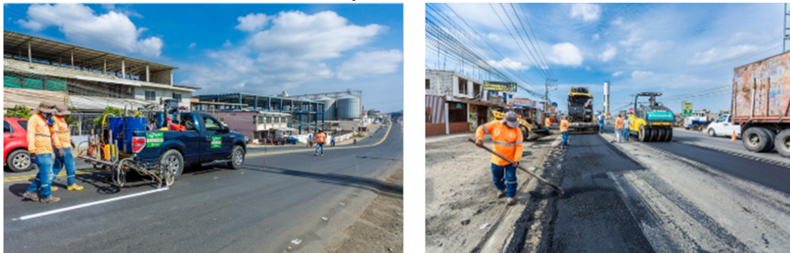
Ilustración 8: Trabajos en la vía Montecristi - Manta
