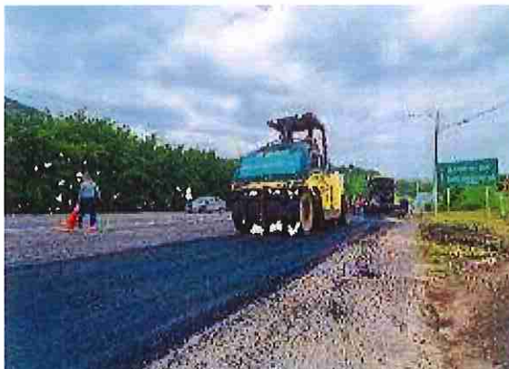
Ilustración 5: Recapeo carpeta asfáltica
