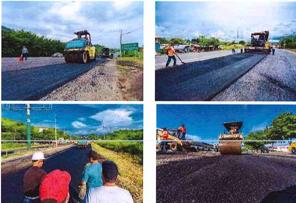
Ilustración 6: Recapeo carpeta asfáltica
