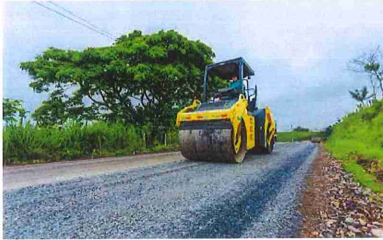
Ilustración 9: Trabajos en la vía Mercedes del Palmar – El Carmen
